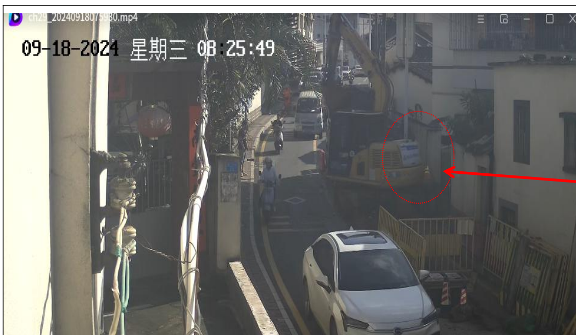
图 1 监控视频中伤者被挖机转台尾部挤压至工地旁边围墙情况
