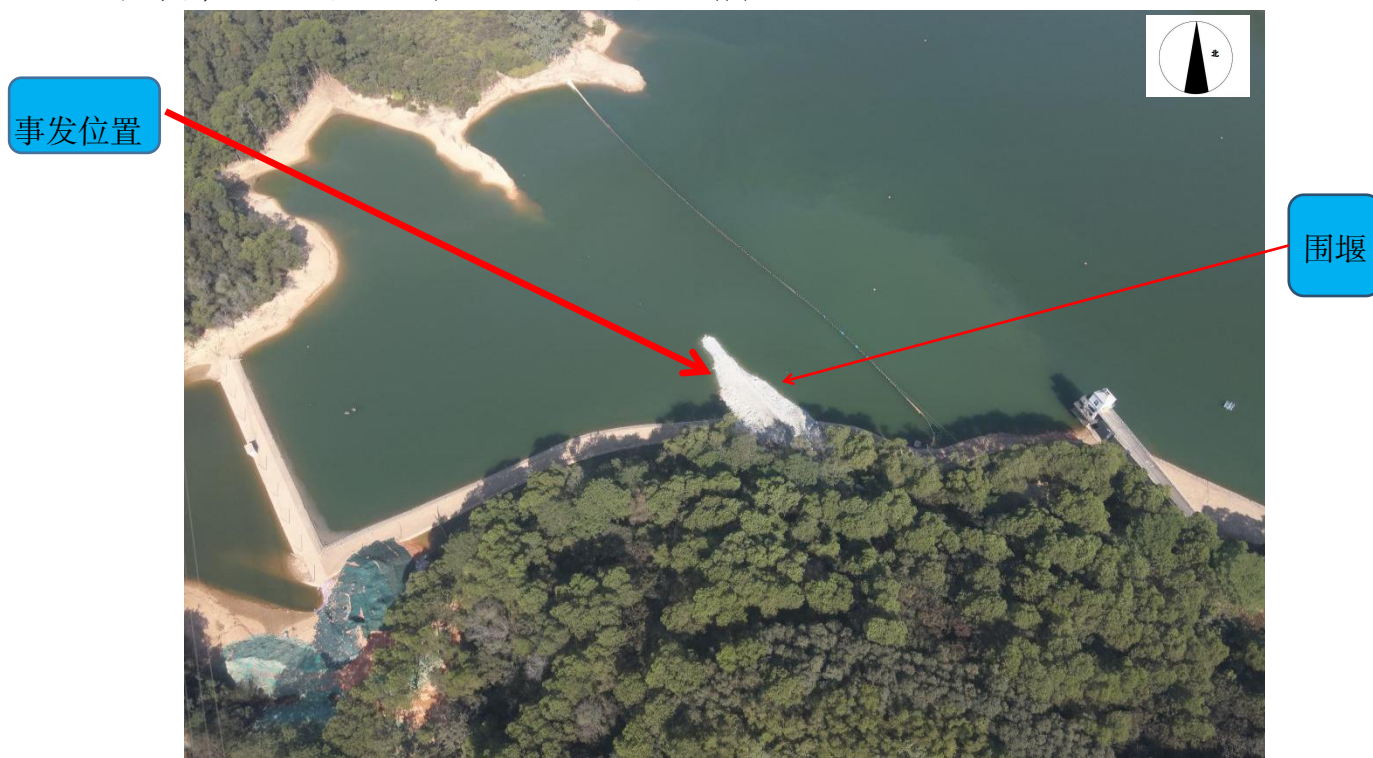
图 3 茜坑水库（局部）航拍图
