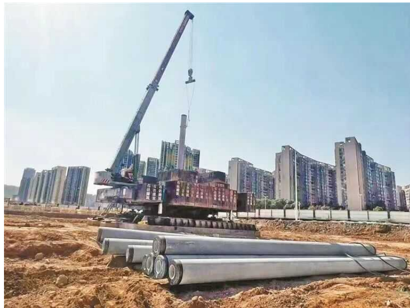
项目建设开工现场图
