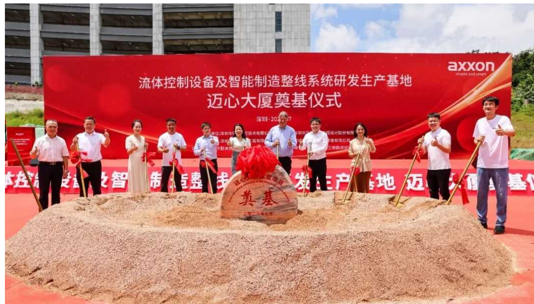
项目建设开工现场图
